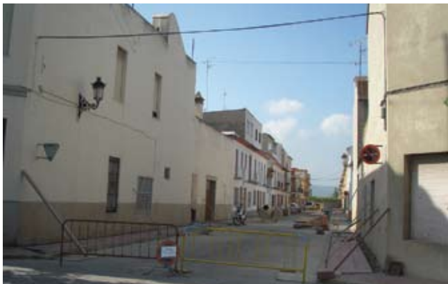
Carrer Jaume Safont durant les obres
