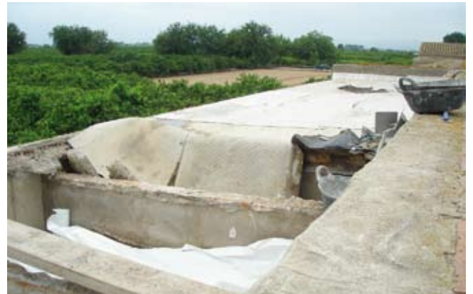
El trespol durant les reparacions
