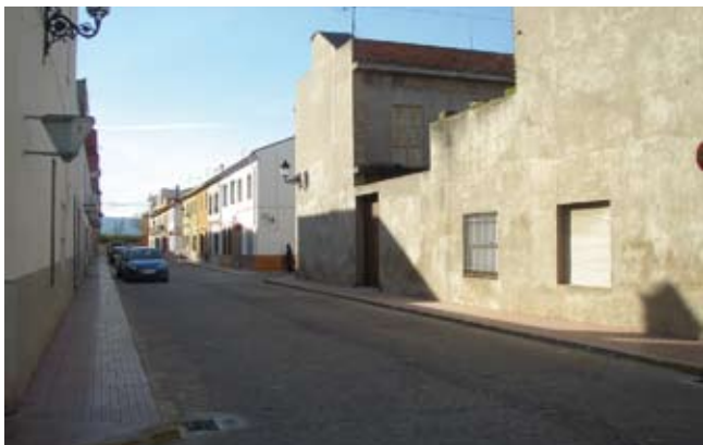
Carrer Jaume Safont, amb les voreres acabades
