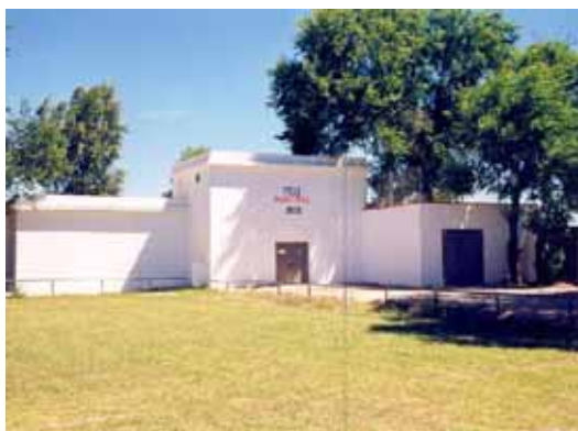
pou d'aigua potable en el poliesportiu municipal
