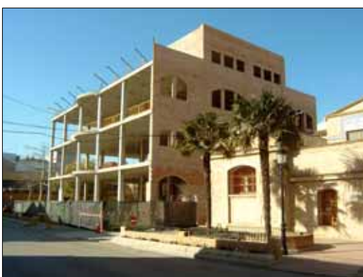
estructura i façana lateral
