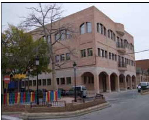
La façana principal, la llotja de la planta baixa que aprofitarà d'espai per esperar els autobusos.
