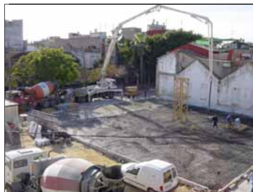
la sola de formigó del fonament
